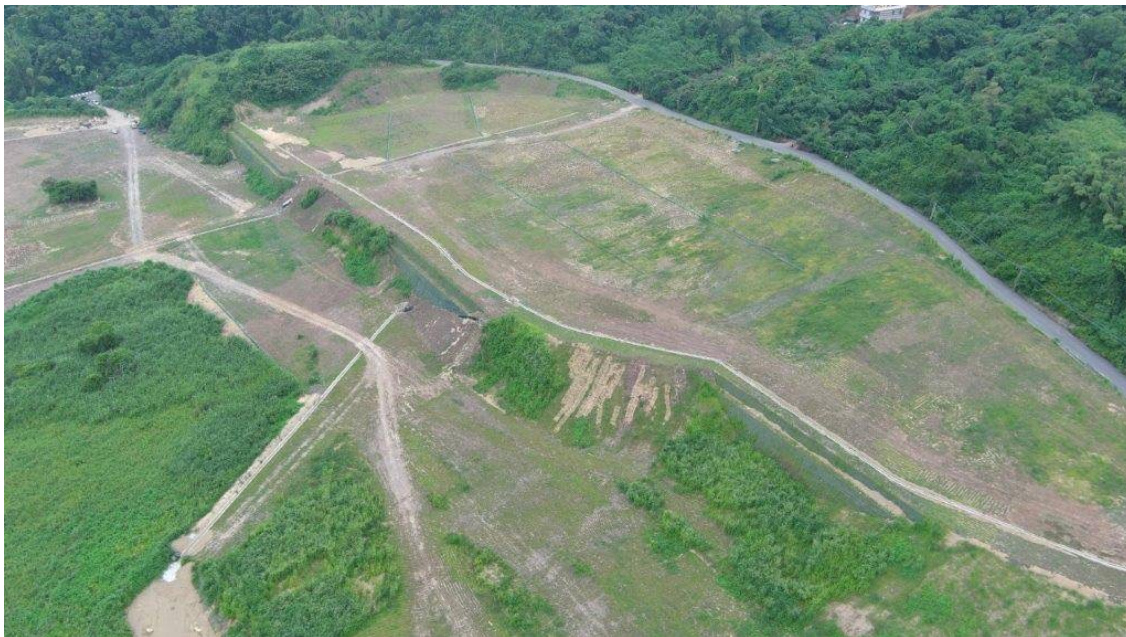
(照片 3：違規太陽能光電板基座已拆除，現場植生已鋪設完成)
