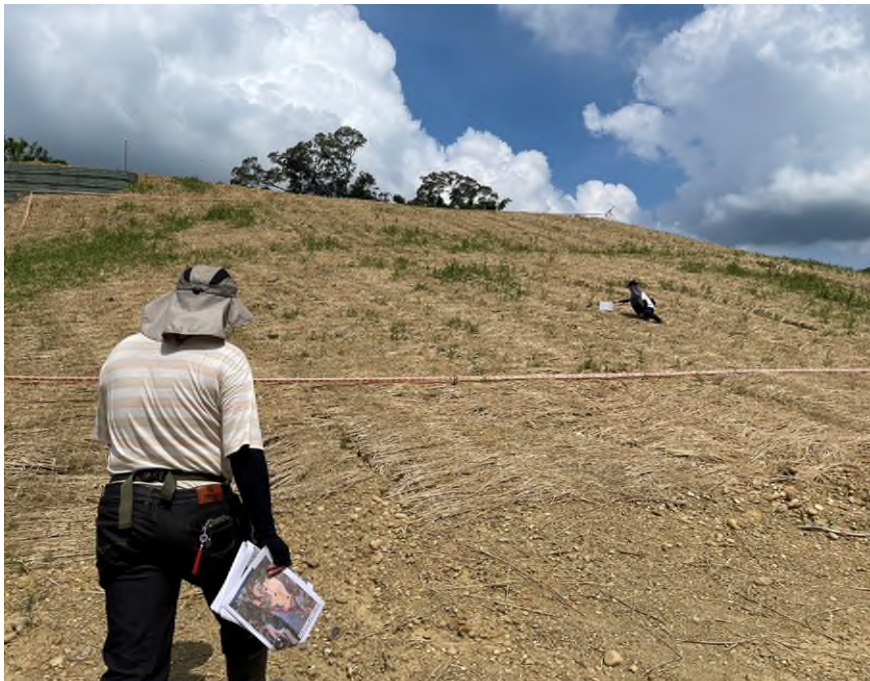
(照片 3：現場勘驗情形 3)
