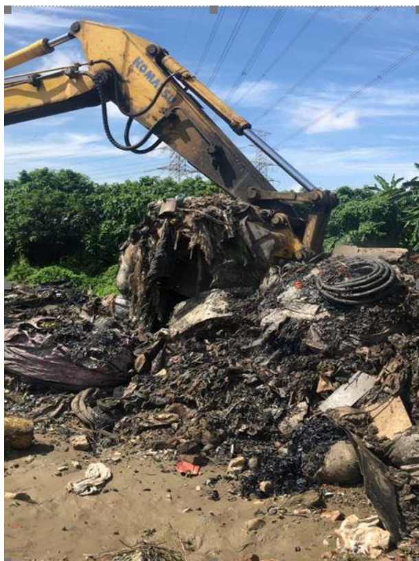
(圖片1：掩埋廢棄物開挖現況)
