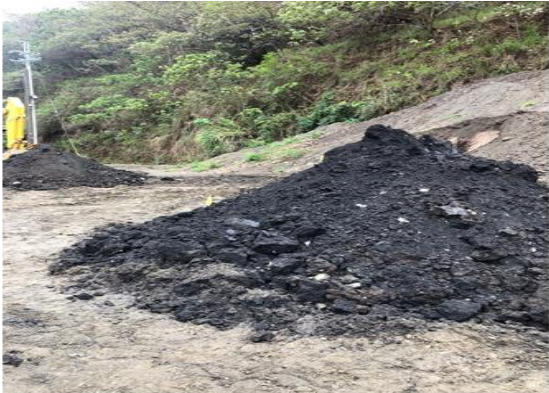
(照片2：現場開挖發現遭回填大量惡臭污泥)
