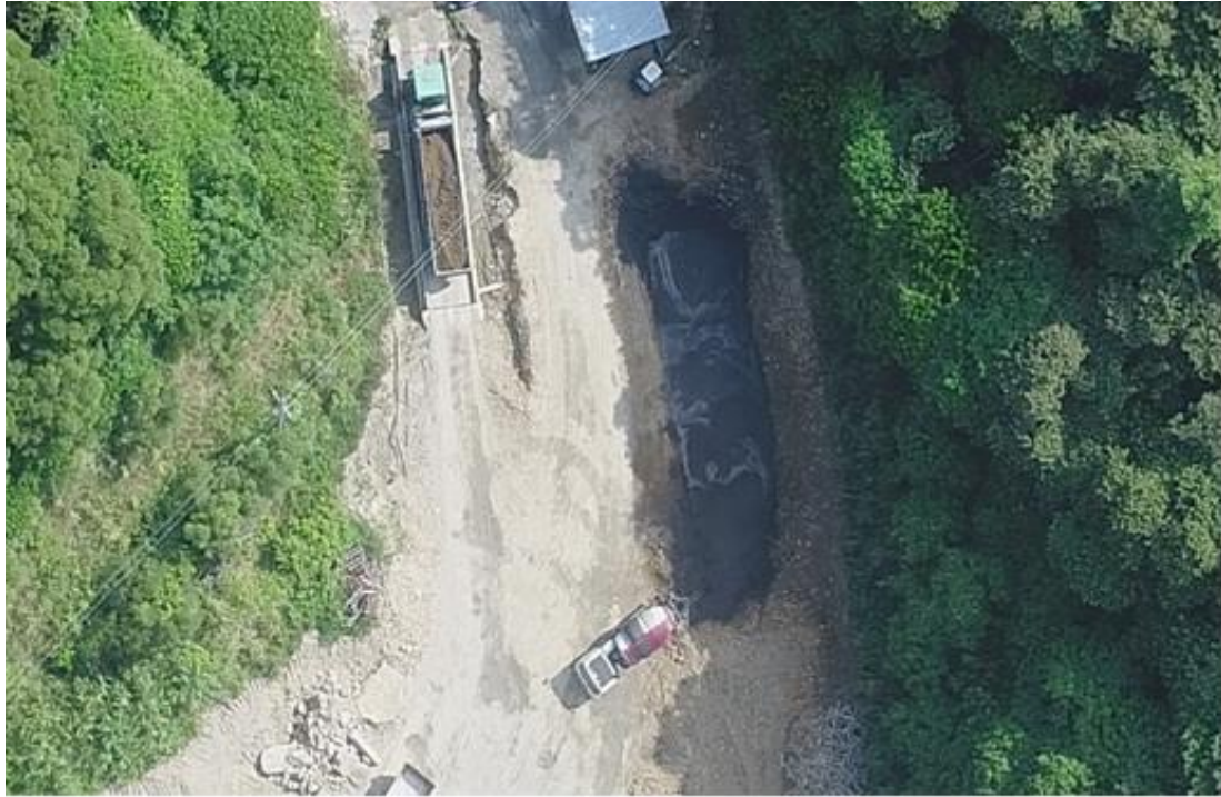
(照片1：現場遭挖掘之情形)
